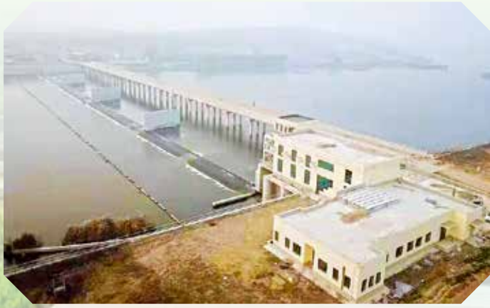
胡城拦河闸除险加固工程
