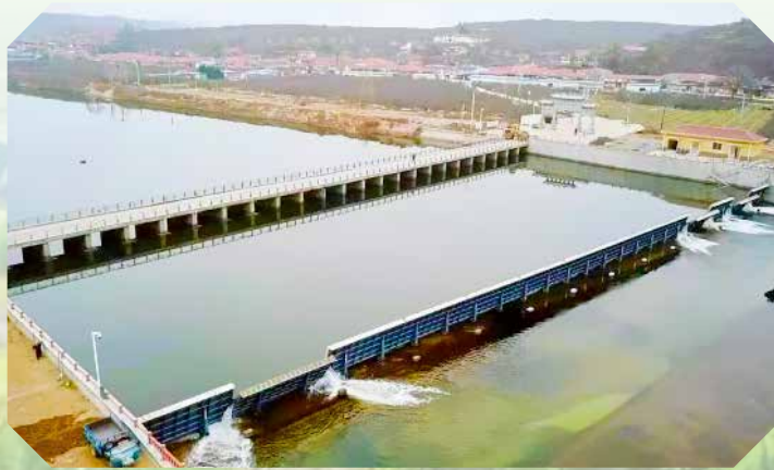
簸箕港拦河闸除险加固工程
